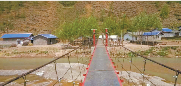
曹礼勇牵头维修新的大坝乡瓦布村的红旗吊桥。
